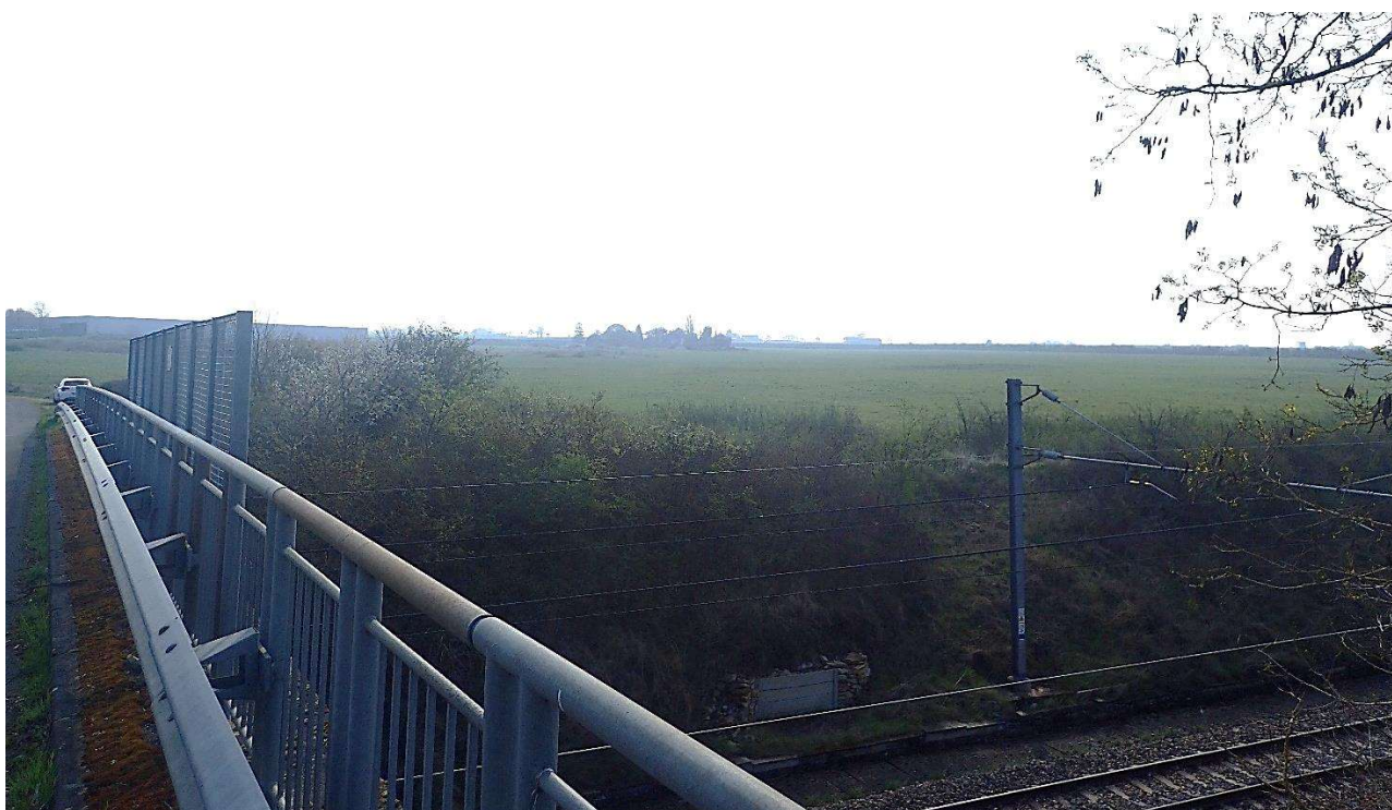
Vue 6 : Photographie depuis le pont au-dessus de la voie ferrée en direction du nord du site de projet au nord-ouest de celui-ci
