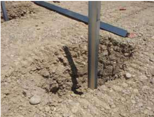
Types de fondation - pieux battus (Source : Guide MEDDTL 2011 – NCA, 2015)
